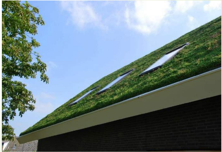
Toiture végétalisée en pente (même jusqu'à 45°). Source : Sempergreen
